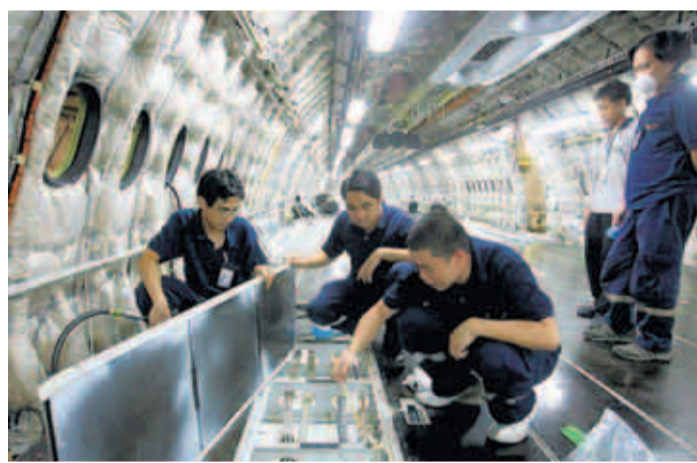
Philippinische Mitarbeiter prüfen Kabelverbindungen, die im Boden der Passagierkabine verlaufen
